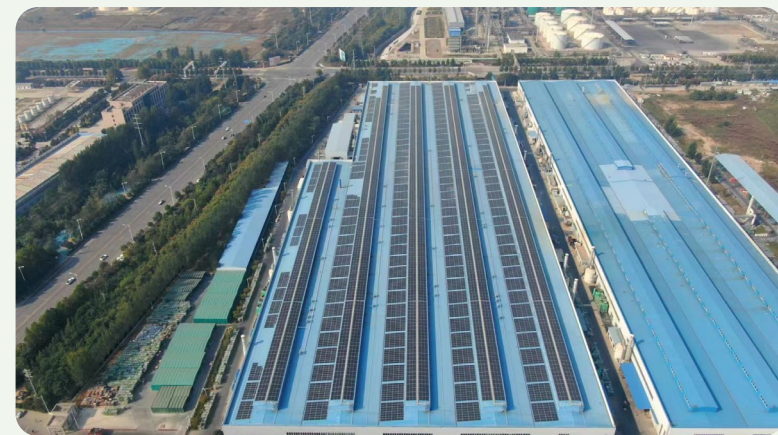
光伏铺设照片
